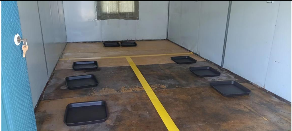
危废暂存间托盘
